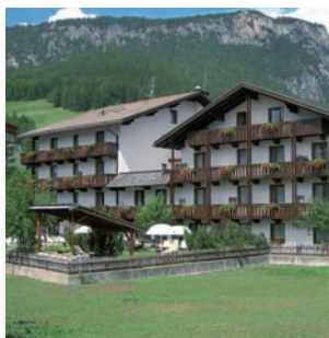
Multiproprietà Residence Astoria Trentino Alto Adige
